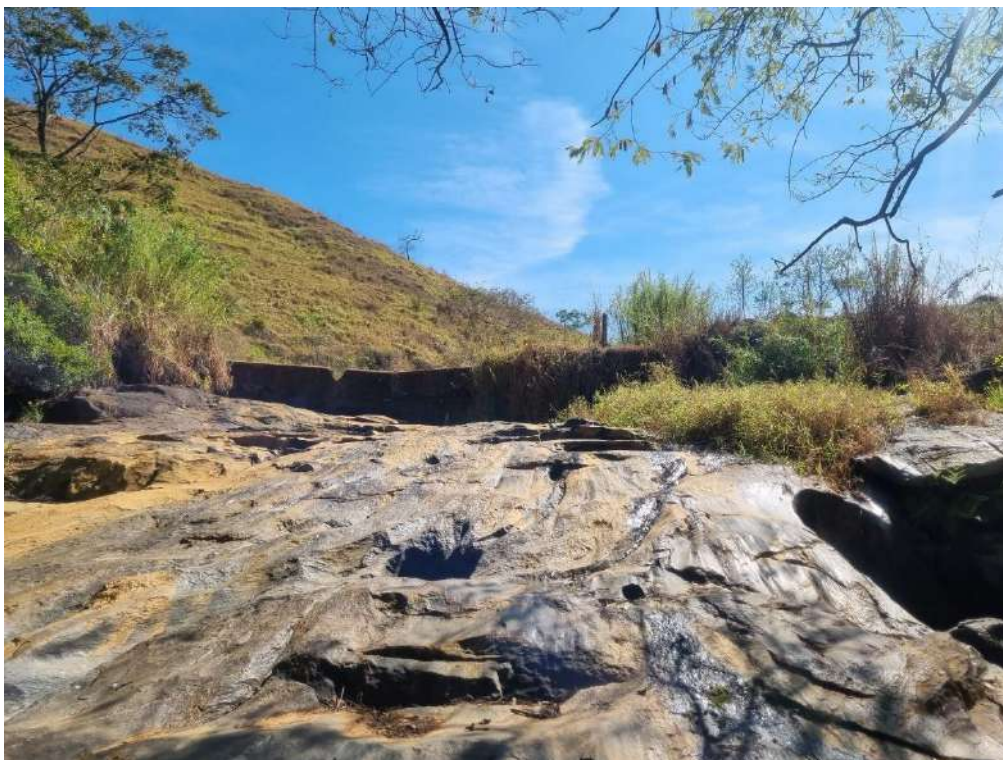
Imagem 32 – Muro de cimento junto às pedras
