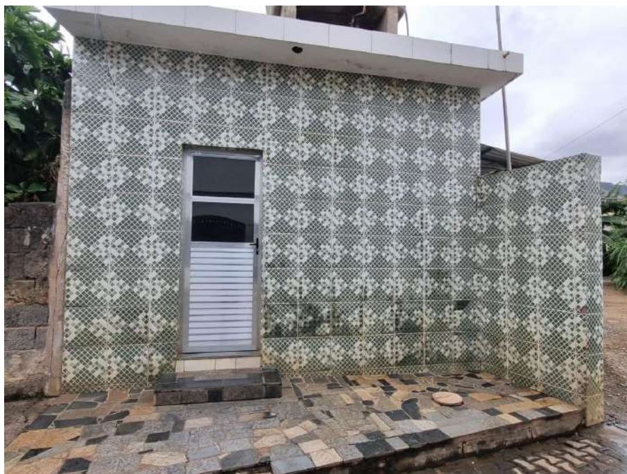
Imagem 76 - Fachada do laticínio
