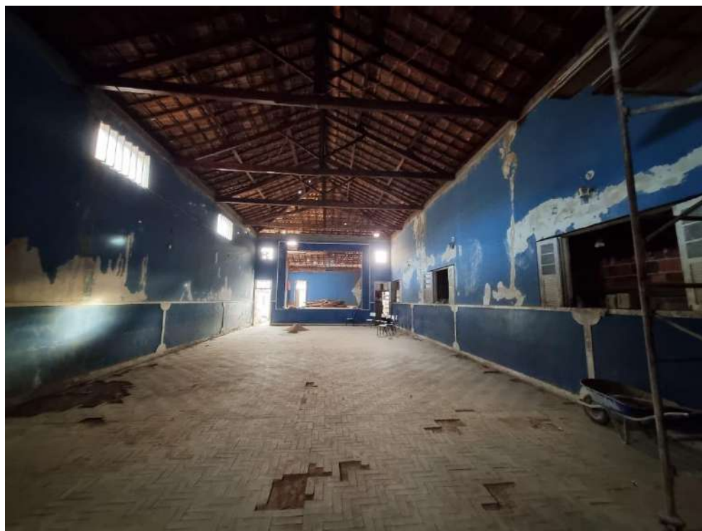
Imagem 44 – Interior do edifício da Sociedade Musical (em reforma)
